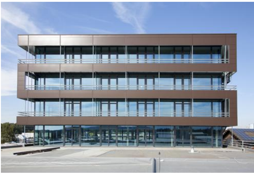
Mehr als 450 Fensterelemente - geschützt mit Sikkens Wood Coatings Holzoberflächenbeschichtungen - gestalten die Fassade des Gewerbebaus. Fotos: Akzo Nobel Wood Coatings GmbH – Sikkens Wood Coatings
